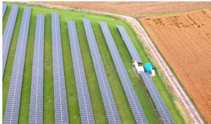
Quelle: Auszug aus © Solar Cluster BW 2021 – Leitfaden „Photovoltaik in Gewerbe und Industrie“; Quelle Foto – Ralf Hofmann
