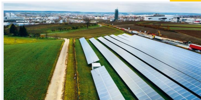
Quelle: Auszug aus © Solar Cluster BW 2021 – Leitfaden „Photovoltaik in Gewerbe und Industrie“; Quelle Foto – Ralf Hofmann
