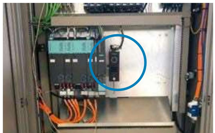
Abbildung 19: Anbringung des Vibrationssensors, des Stromwandlers und des dEdge
